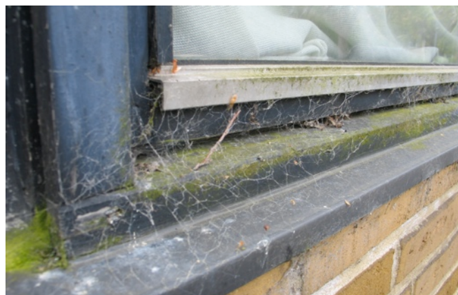
Råddent træværk og murværk der skaller af, gør det nødvendigt at renovere i Byparken og Skovparken
